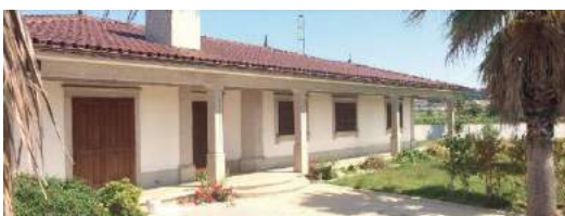
Residência de Treino de Autonomia de Infância e Adolescência, Associação Recovery (Barcelos)
