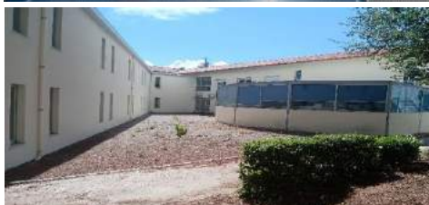
Requalificação do serviço de ambulatório da ULS de Trás-os-Montes e Alto Douro
