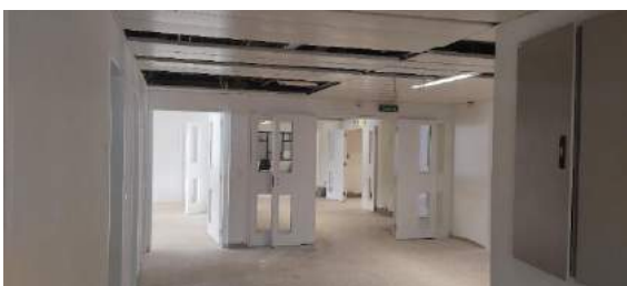
Requalificação da ULS de Castelo Branco concluída em 30.04.2023
