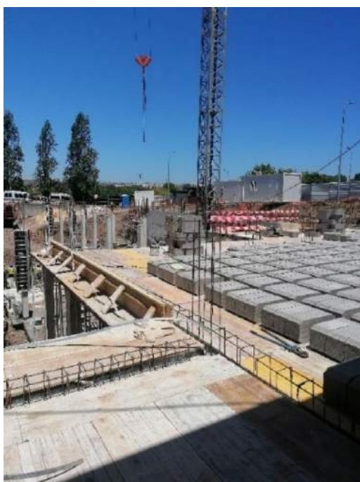
Construção da unidade de internamento da ULS de Amadora/Sintra (Hospital Prof. Doutor Fernando Fonseca)
