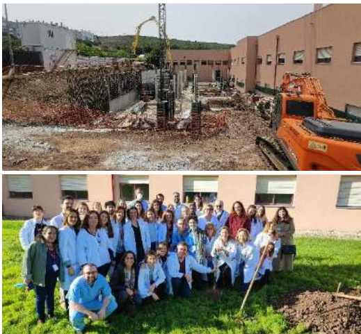
Construção da unidade de internamento na ULS Amadora/Sintra (Hospital Fernando Fonseca)
